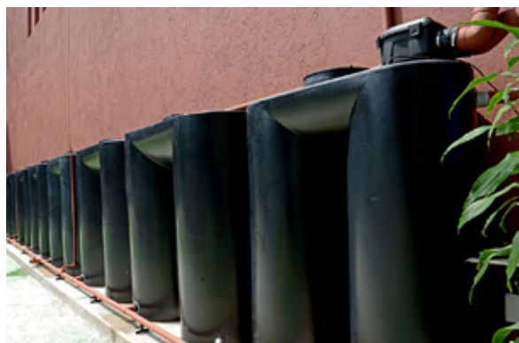
En 2024 se adquirió e instaló un sistema de captación de agua pluvial en el edificio sede de la Comisión.
