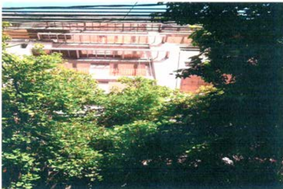
Edificio terminado en el inmueble
