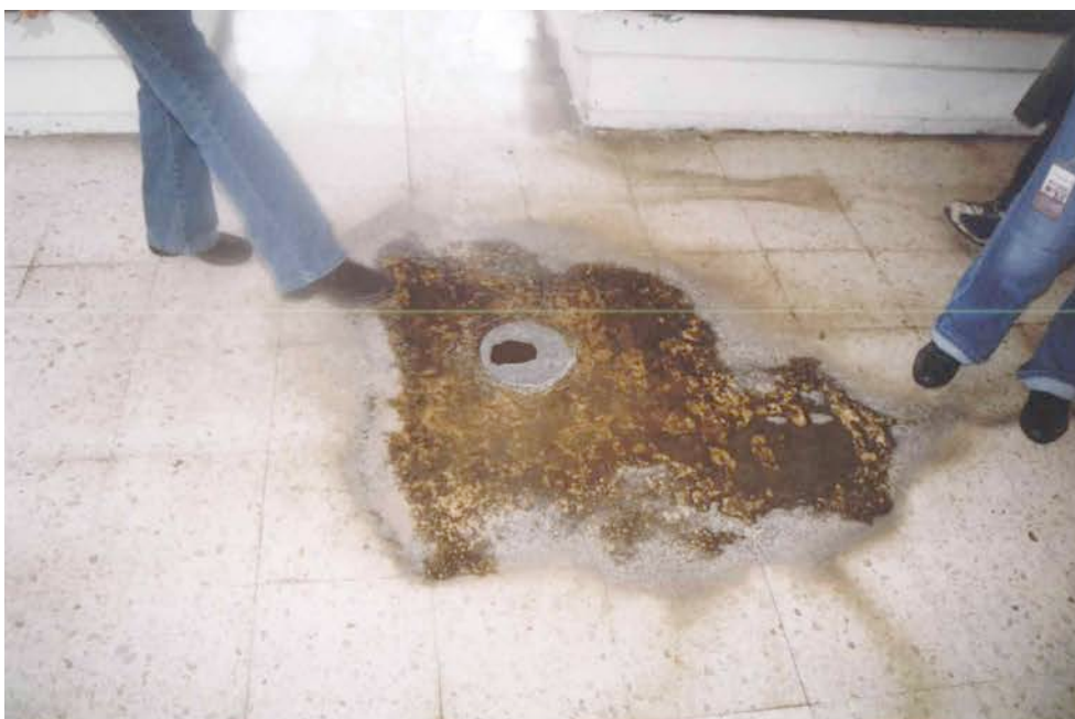
Foto 31, tomada en el área de dormitorio del C.A.I.S. "Cuemanco", el 10 de febrero de 2012.
