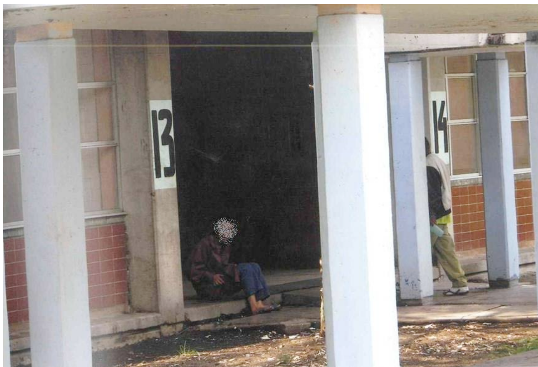
Foto 36, tomada en el área de dormitorio del C.A.I.S. "Cuemanco", el 10 de febrero de 2012.
